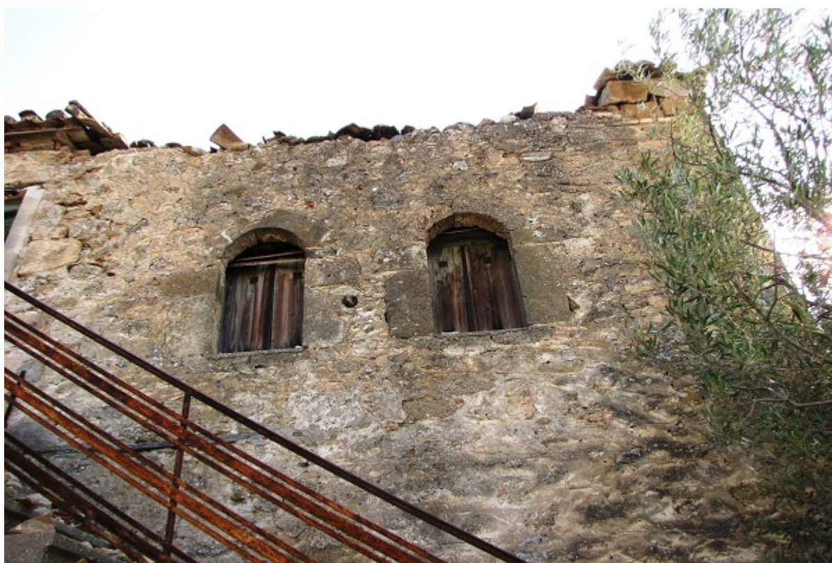
Εικόνα 6: Αποψη των δύο εκ των τριών τοξωτών παραθύρων του δευτέρου ορόφου της νοτιοδυτικής πλευράς (πρόσοψη). Εκτιμάται ότι ανήκουν στην αρχική κατασκευή του πυργόσπιτου.
