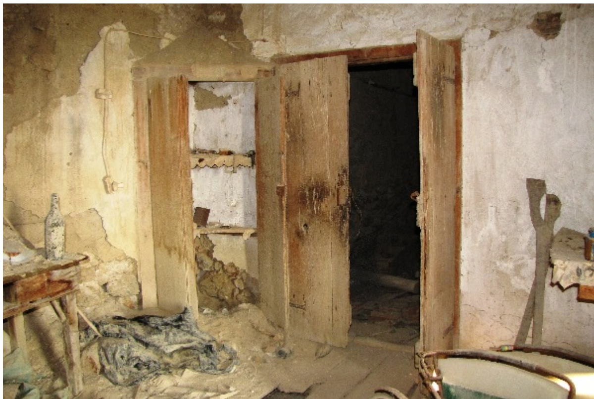
Εικόνα 10: Η εσωτερική ξύλινη δίφυλλη διαχωριστική πόρτα μεταξύ των δύο θαλάμων του ισόγειου ορόφου με ένα επιτοίχιο ερμάριο ακριβώς δίπλα της.
