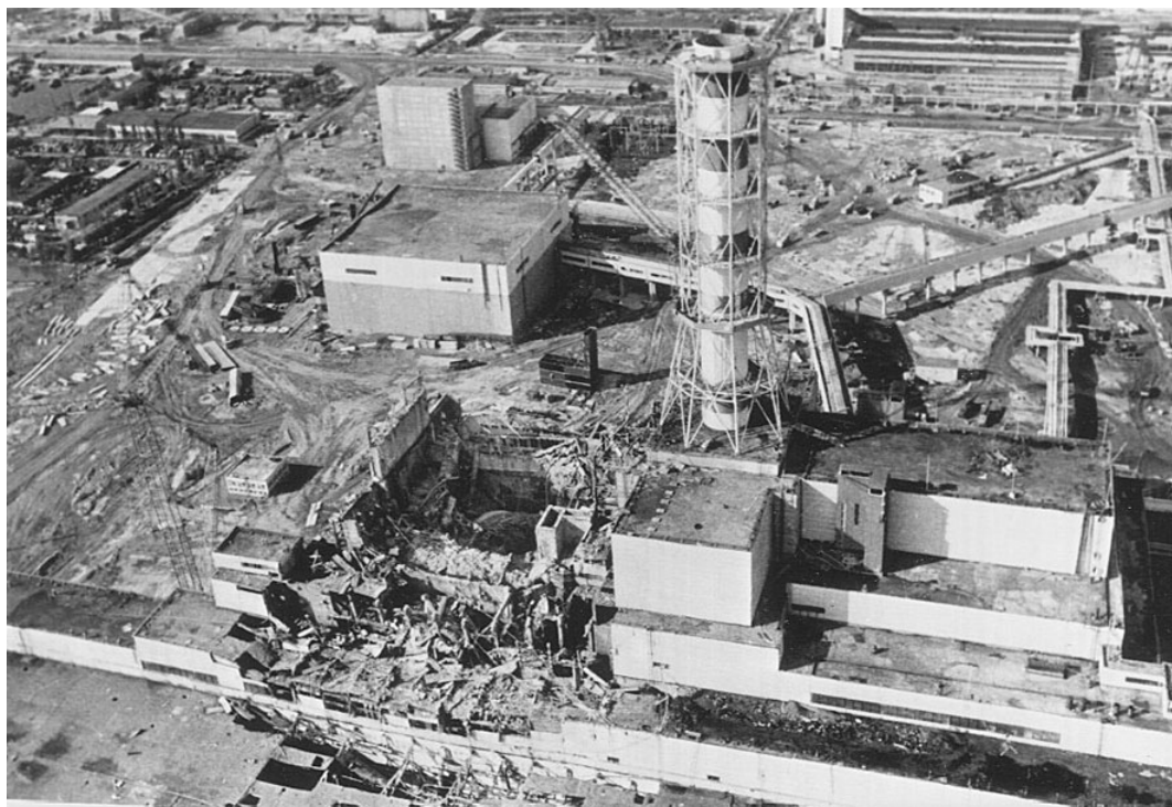
Λίγο μετά το ατύχημα οι εργασίες για την ανέγερση της σαρκοφάγου γύρω από τον περιβόητο αντιδραστήρα έχουν αρχίσει.
