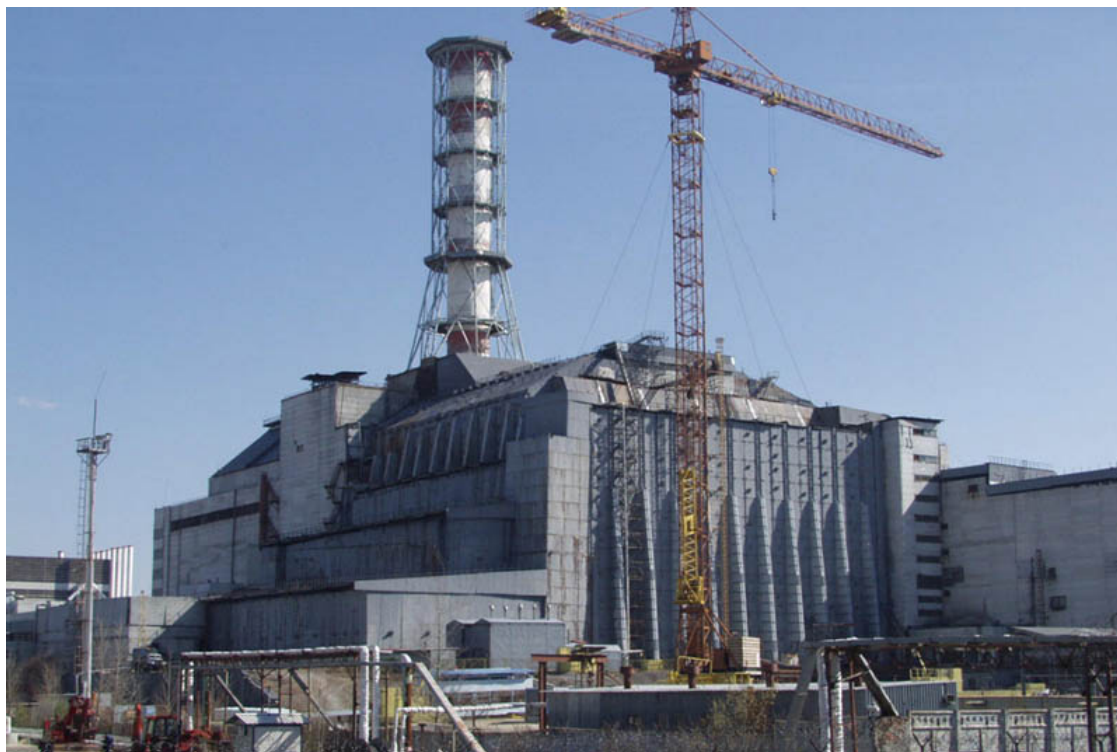
Η σαρκοφάγος που έχτισαν οι Σοβιετικοί για να καλύψουν τον κατεστραμμένο αντιδραστήρα και να εγκλωβίσουν την εξάπλωση της ραδιενέργειας μόνο προσωρινά έλυσε το πρόβλημα.
